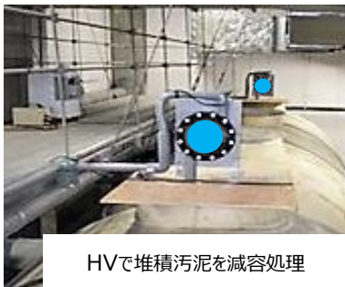
長期間ブロー停止で嫌気汚泥堆積と悪臭、HVで堆積汚泥を減容と臭気ゼロとなる
